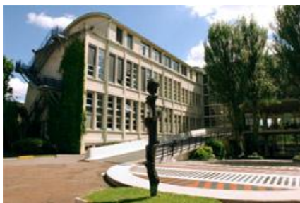
Bâtiment d'Alembert (①)
